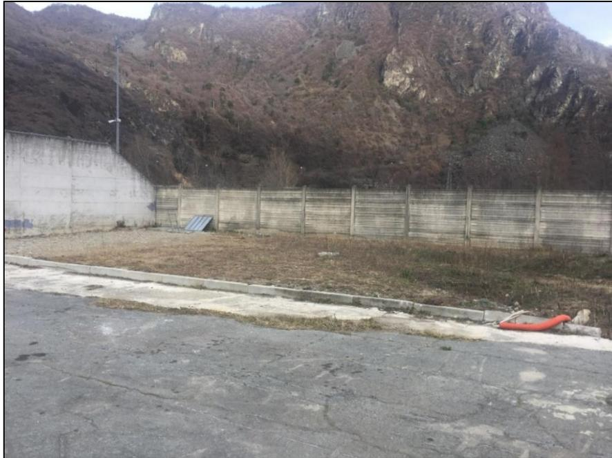
Figura 5: Recinzione in cls lungo il confine orientale posizionata a tetto del muro di contenimento in C.a.
